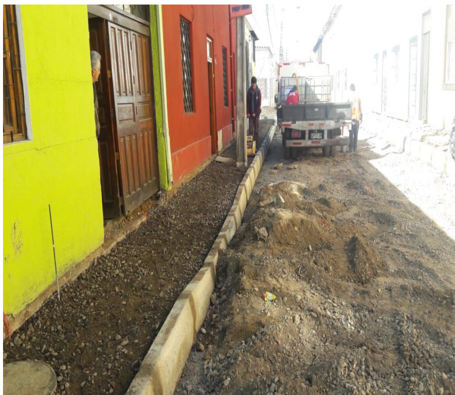
COLOCACION BASE ESTABILIZADA E INSTALACION SOLERAS CALLE SAN LUIS
