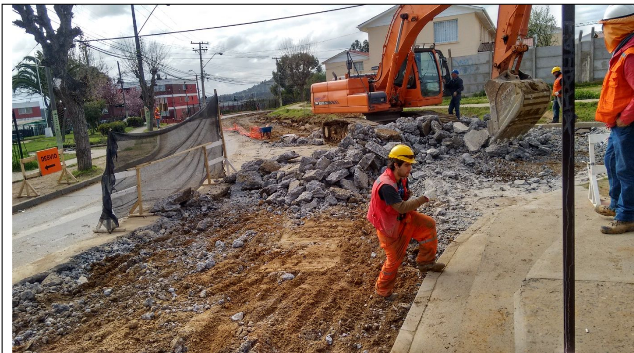
DEMOLICION CALZADA EXISTENTE AV. GOMEZ CARREÑO
