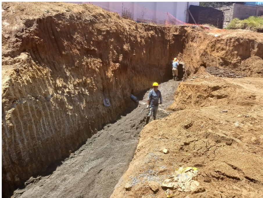
EXCAVACION PARA ALCANTARILLADO PUBLICO ESVAL
