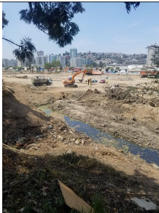
DEMOLICION PAVIMENTO EXISTENTE EN EL LECHO DEL ESTERO
