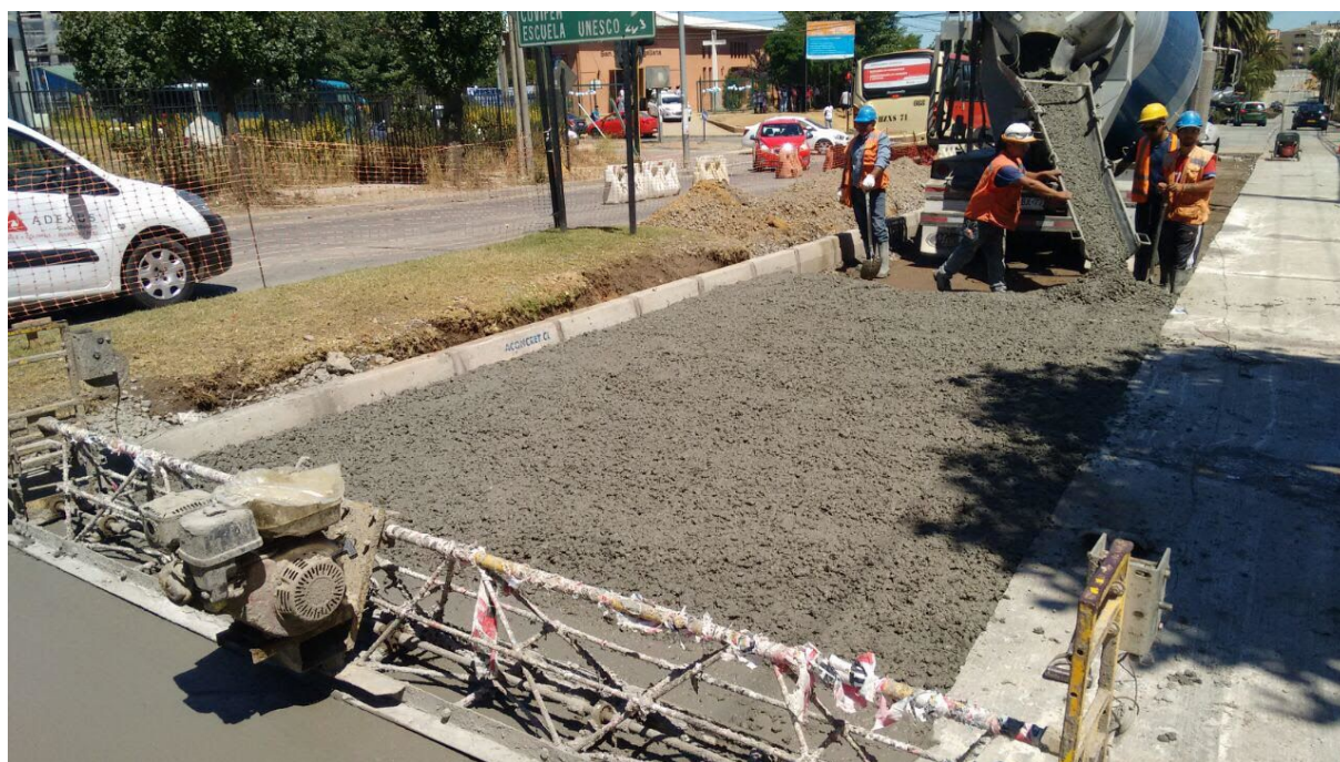
HORMIGONADO CALZADA AV. GOMEZ CARREÑO
