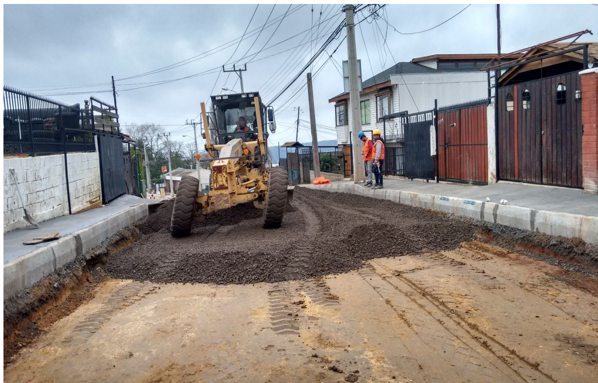
COLOCACION BASE ESTABILIZADA CALLE ALEJANDRO NAVARRETE
