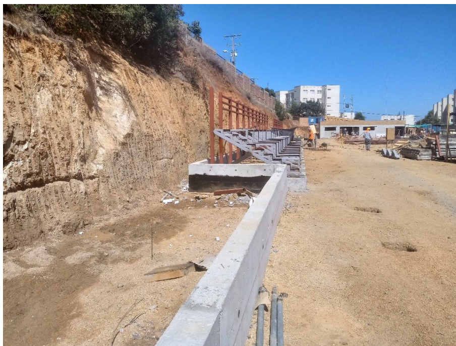
CONSTRUCCION DE MUROS DE CONTENCION Y GRADERIAS METALICAS.
