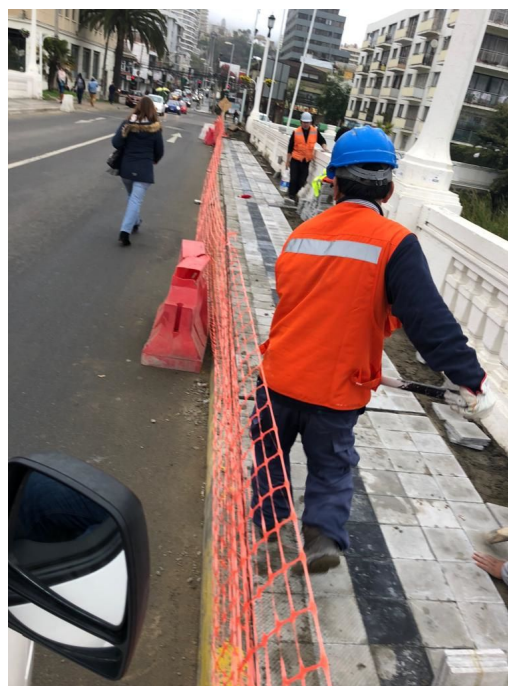
Instalación de nuevas baldosas Puente Villanelo
