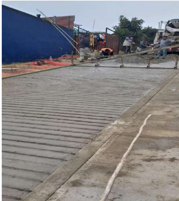
CONSTRUCCION CALZADA ESTRIADA POR FUERTE PENDIENTE
