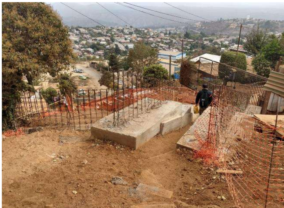
FUNDACION Y ENFIERRADURA PARA MUROS DE HORMIGON ARMADO
