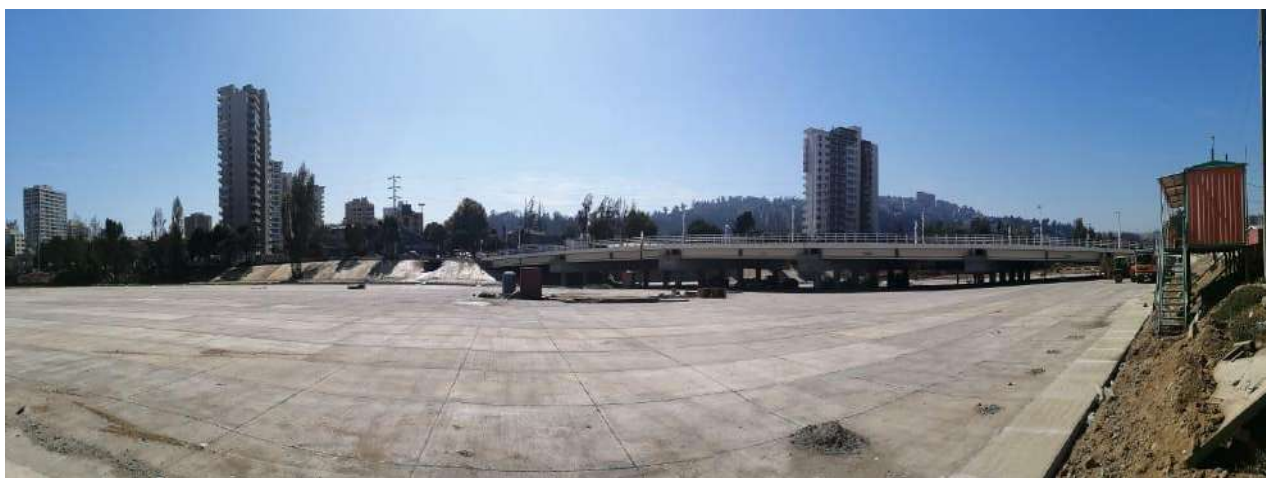
REVESTIMIENTO LECHO ESTERO EN HORMIGON DE CALZADA PARA FUNCIONAMIENTO DE FERIA
