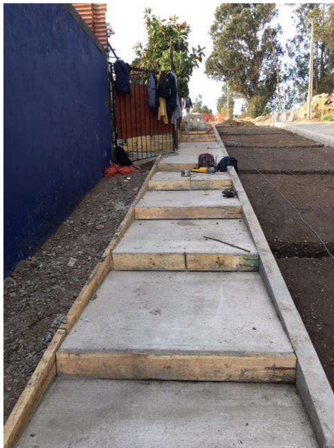
CONSTRUCCION DE ACERAS ESCALONADAS
