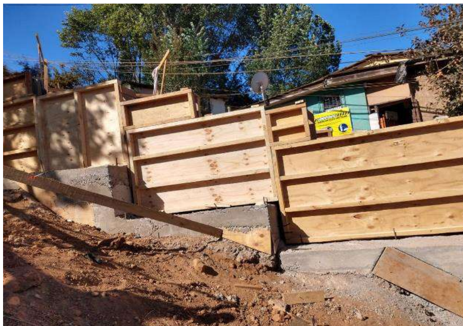
MOLDAJES PARA MUROS DE HORMIGON ARMADO
