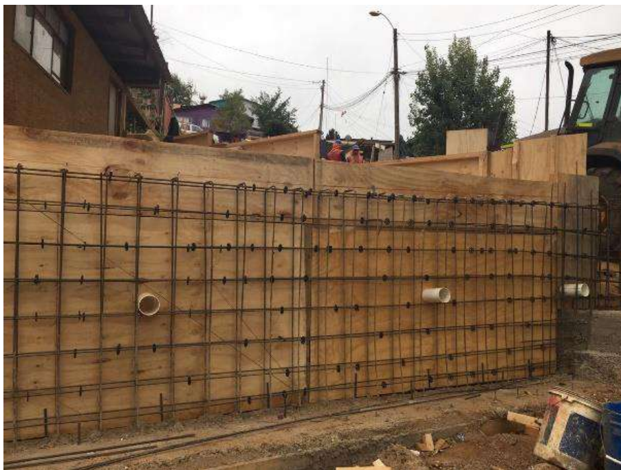
ENFIERRADURA DE MUROS DE CONTENCION
