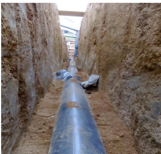
Instalación Colector de Alcantarillado, Puerto Williams
