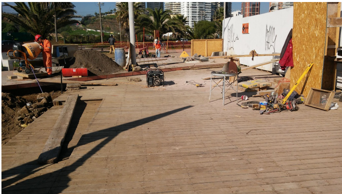
Reposición paseo de madera y baldosas, tras la instalación de colector, vista oriente
